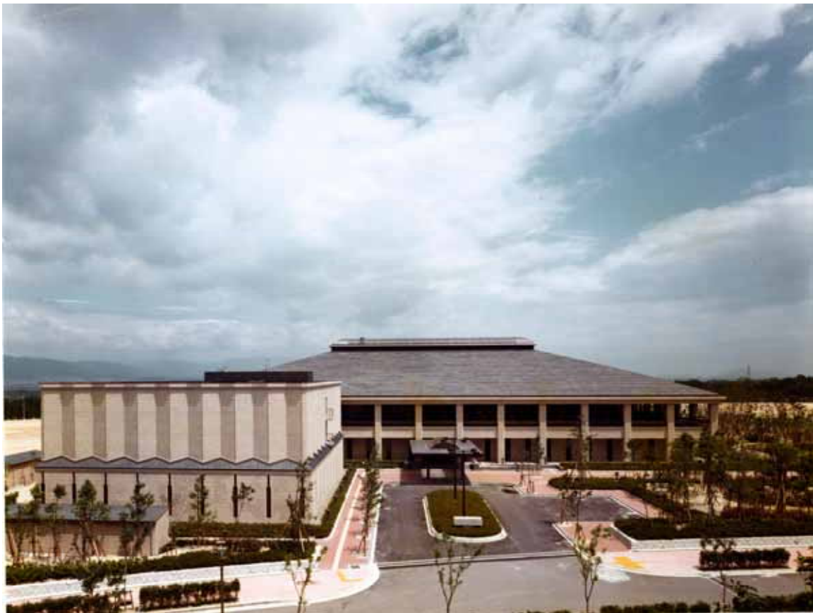
県立図書館竣工（1980年3月）
